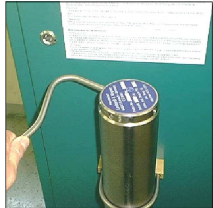
Abb. 1 - Abschrauben des Filtergehäuse-Deckels
