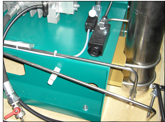
Zu entfernende Rohrleitung
