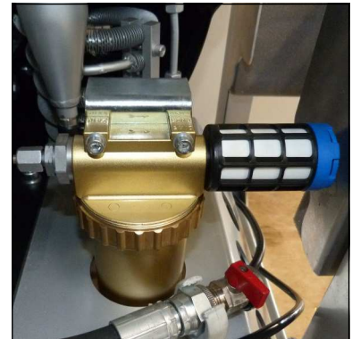
Öl- / Wasserabscheider Endstufe
