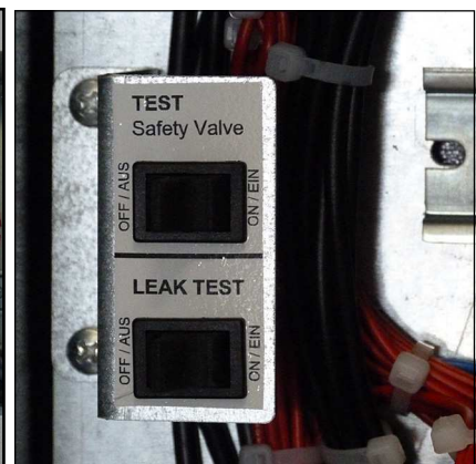
Sicherheitsventil-Test-Schalter (oben)
