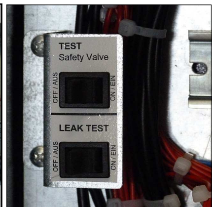
Sicherheitsventil-Test-Schalter (oben)
