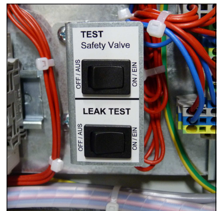
Sicherheitsventil-Test-Schalter (oben)
