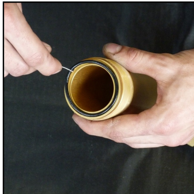
Abb. 5 - O-Ring wechseln
